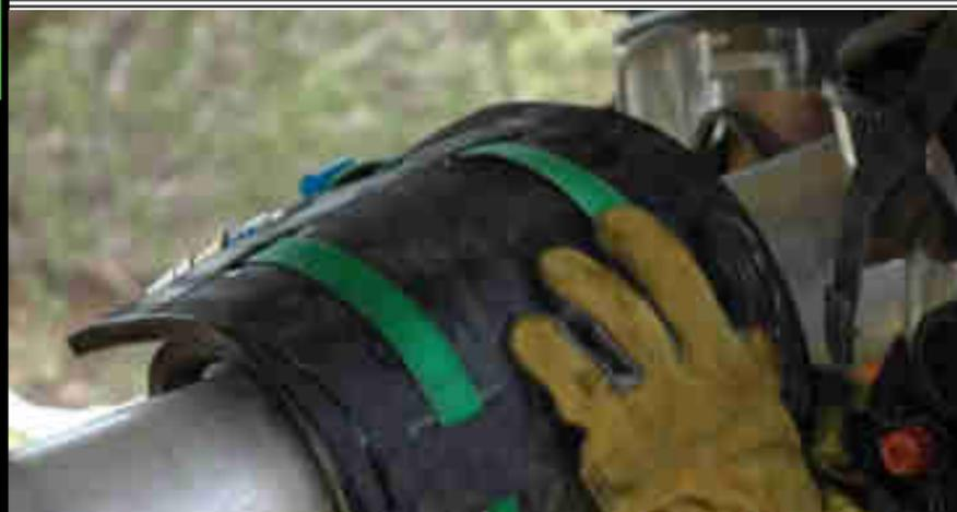
密封绑带用于从外部密封管道。绑带由高度耐化学性物质的橡胶复合材料制成，在大多数要求高的应用场合和情况下保持了高度的灵活性。
